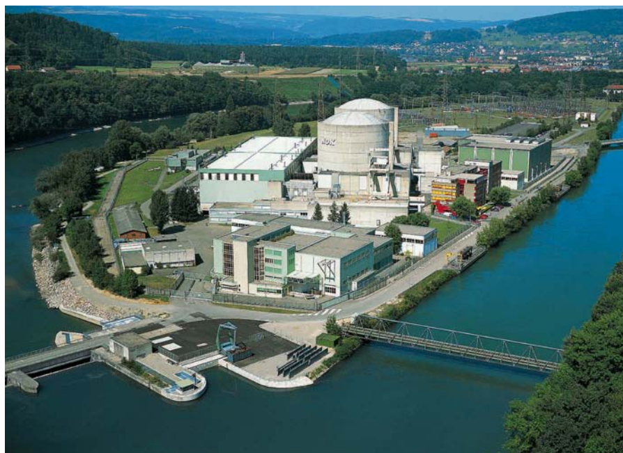
Kernkraftwerke Beznau 1 + 2, Wehrkraftwerk Beznau sowie Hydraulisches Kraftwerk Beznau
